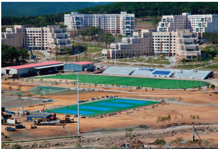
Рис. 19. Строительство кампуса Дальневосточного федерального университета
