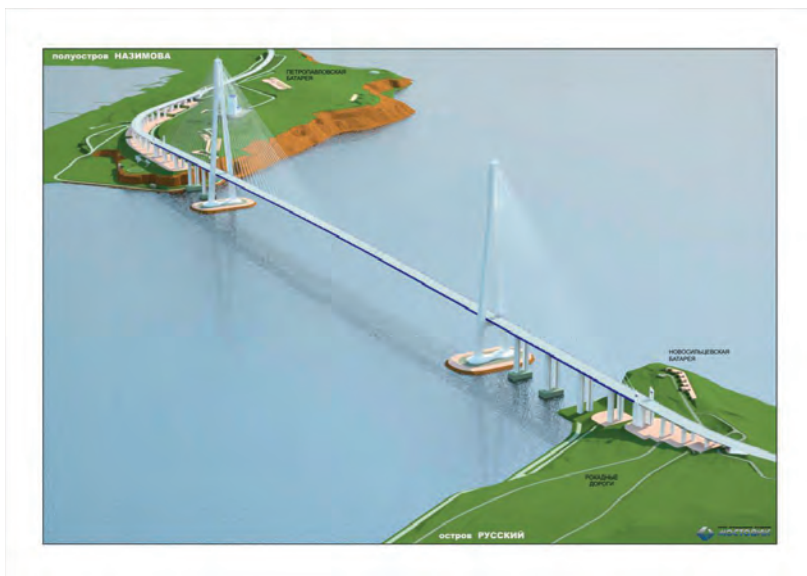
Рис. 18. Мост через пролив Босфор Восточный
